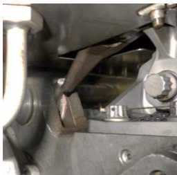
4c. Broken ABG link
